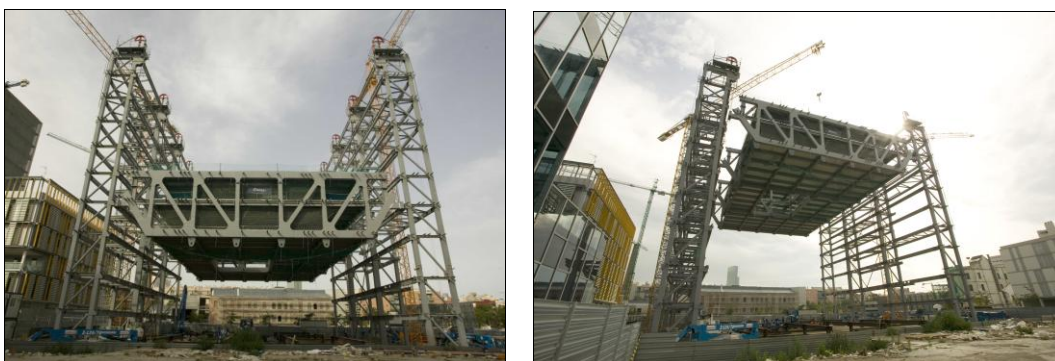
Instantànies de l'hissament de l'estructura
