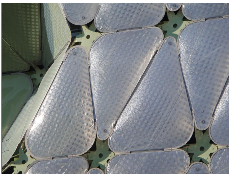
Detall d'una de les bosses mòbils que funcionen com a pantalla solar
