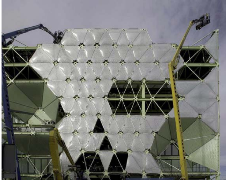
Obras de recubrimiento de la fachada, con la característica piel de ETFE
