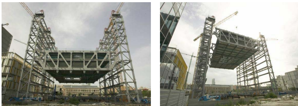
Instantáneas del izamiento de la estructura
