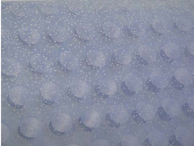
Visto de cerca la serigrafía de ETFE presenta varias capas a la exposición solar
